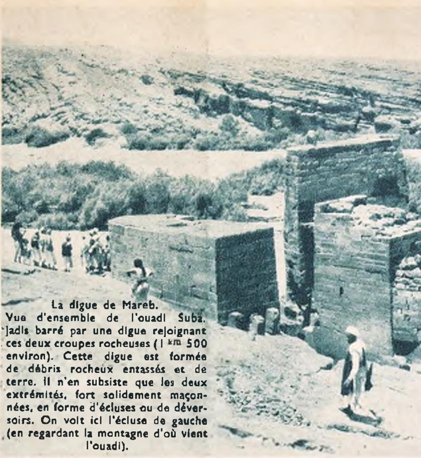
La digue de Mareb. Vue d'ensemble de l'ouadi Subā. Jadis barré par une digue rejoignant ces deux croupes rocheuses (1 km 500 environ). Cette digue est formée de débris rocheux entassés et de terre. Il n'en subsiste que les deux extrémités, fort solidement maçonnées, en forme d'écluses ou de déversoirs. On voit ici l'écluse de gauche (en regardant la montagne d'où vient l'ouadi).
